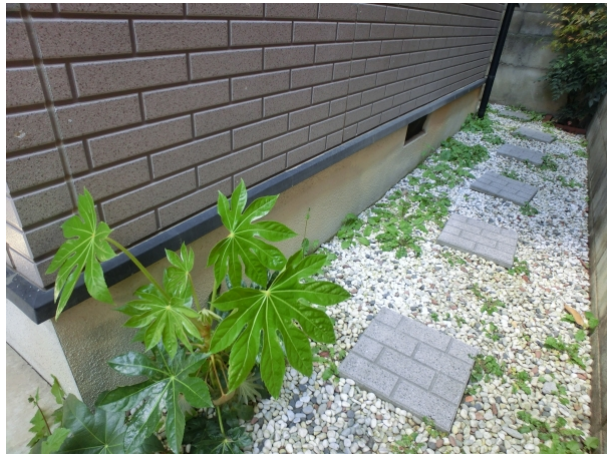
基礎 > 基礎表面 > モルタル仕上げ
