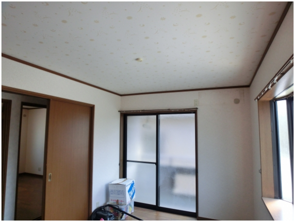
天井＞仕上げ材表面＞壁紙等
