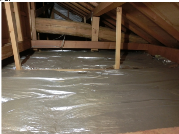
小屋裏 > 断熱材
