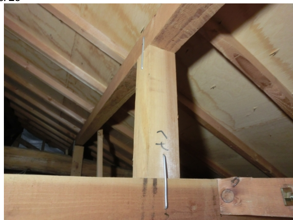
小屋裏 > 接合部
