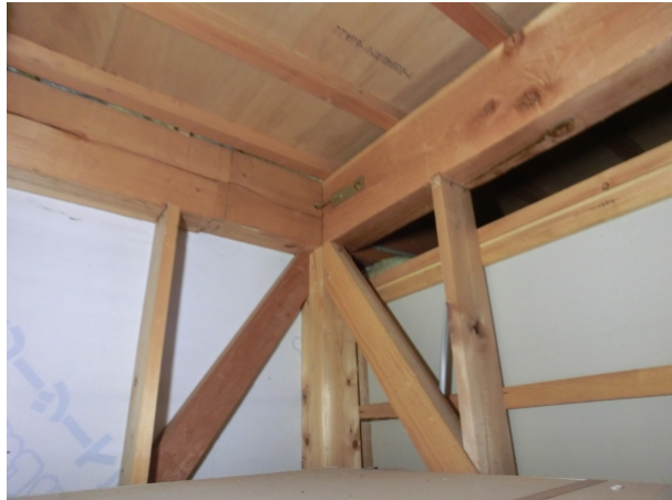
各階間の天井裏・下屋の小屋裏 ＞ 梁、野地板等
