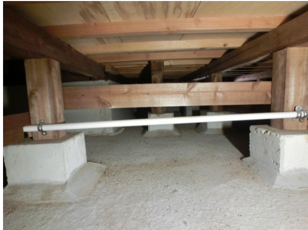
土台および床組 > 土台、大引き、根太等
