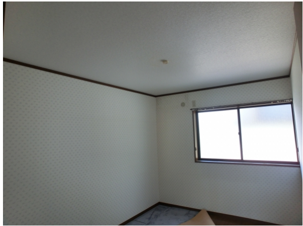
天井＞仕上げ材表面＞壁紙等
