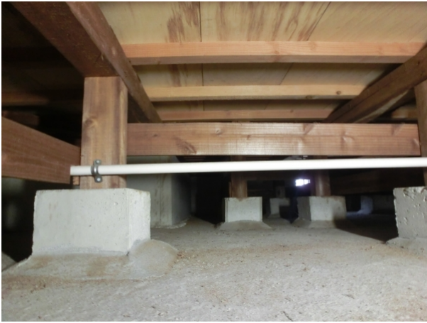
土台および床組 > 断熱材
