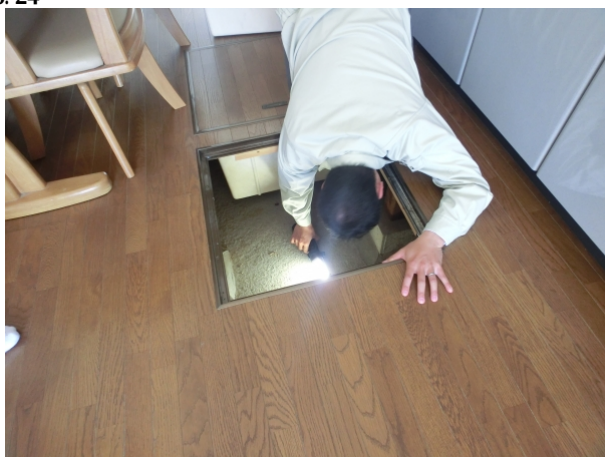
基礎および床下面 > 床下面 > 防湿コンクリート
