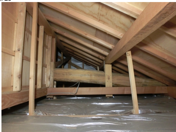
小屋裏 > 梁、小屋組および野地板等
